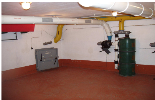
Объект гражданской обороны ОАО «Симферопольская макаронная фабрика»
